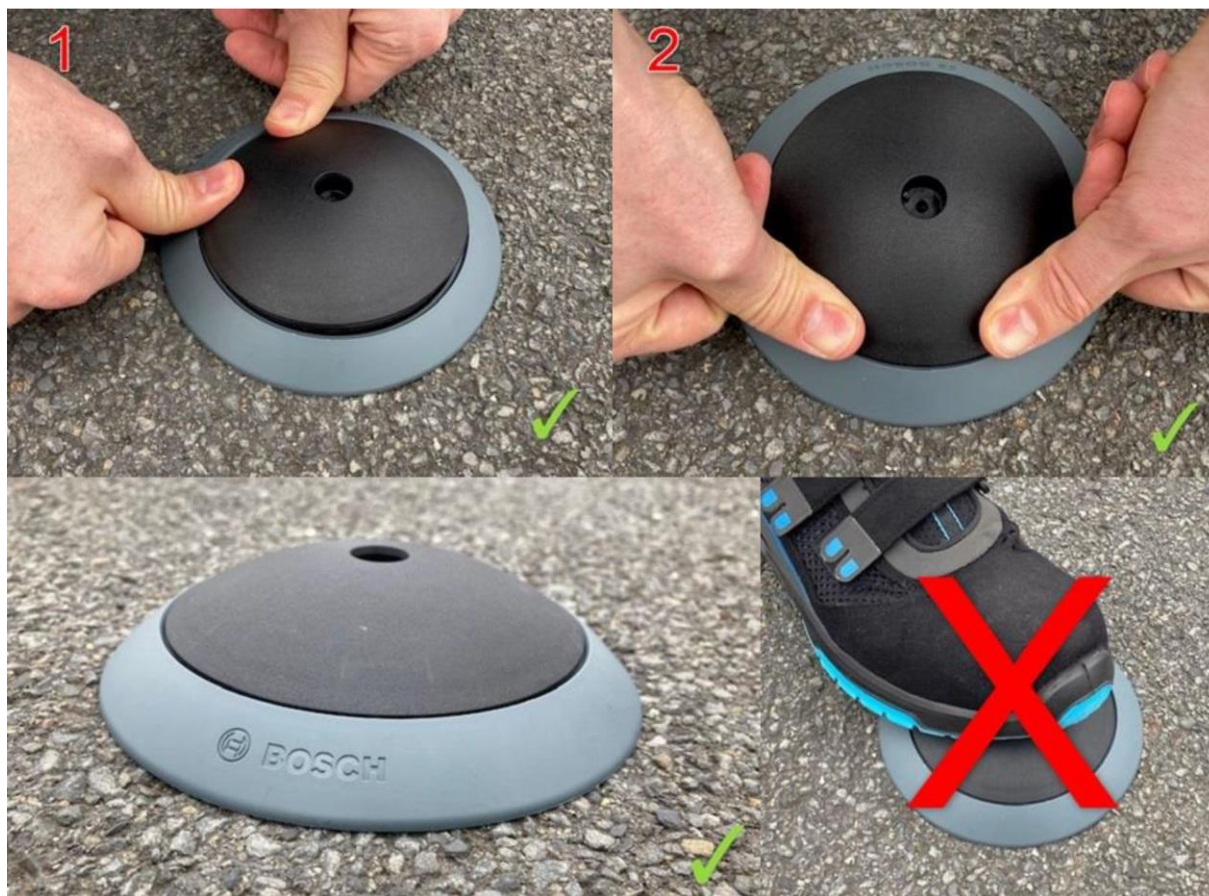
Figur 11 Installation af sensoren – eksempel
