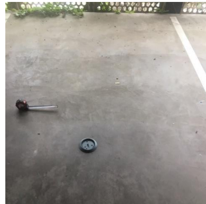
Illustration 9 Socle de capteur installé
