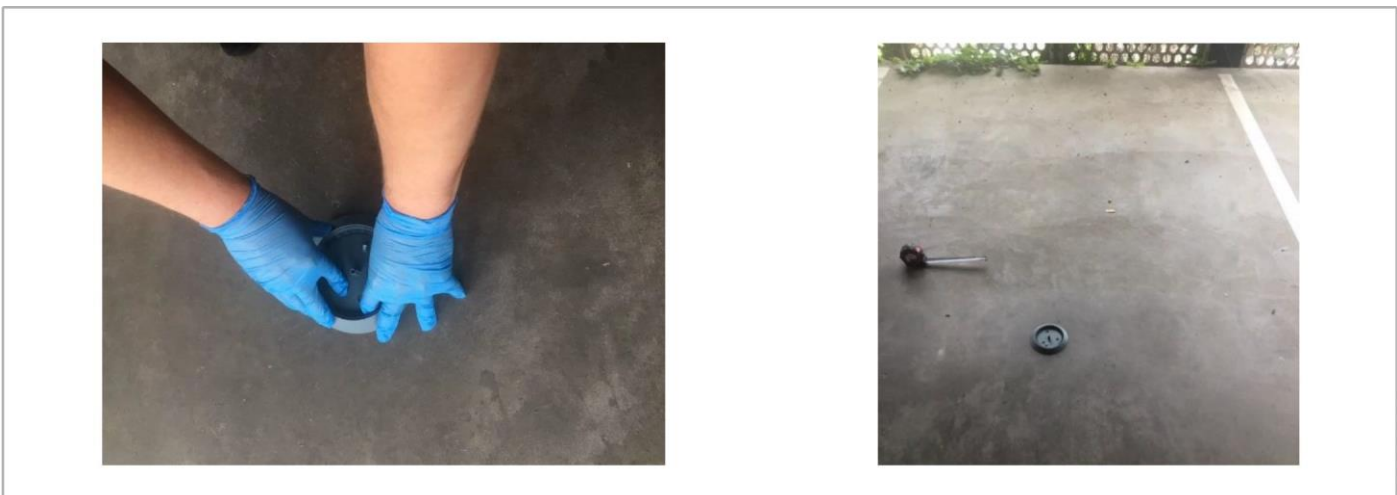
Figura 8 Fissaggio della base del sensore
