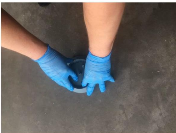
Figura 8 Fixação da base do sensor
