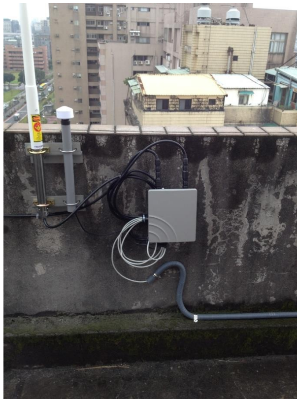
Abbildung 32 6 PVC-Kabelschutzschlauch
