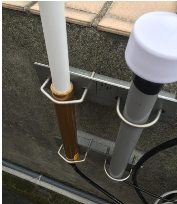
Abbildung 26 Maßgeschneiderte Metallhalterung – Bild 2
