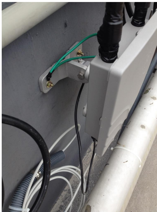
Abbildung 31 Blitzschutz und Erdungsvorrichtungen – Bild 2
