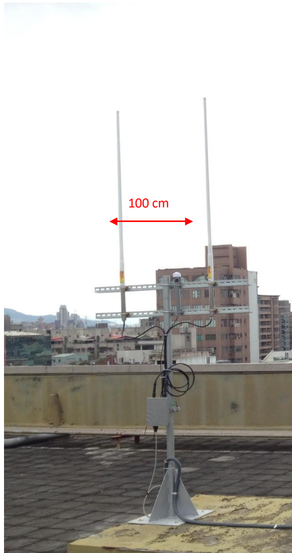
Abbildung 33 Tatsächliche Ansicht einer Installation auf Sockel
