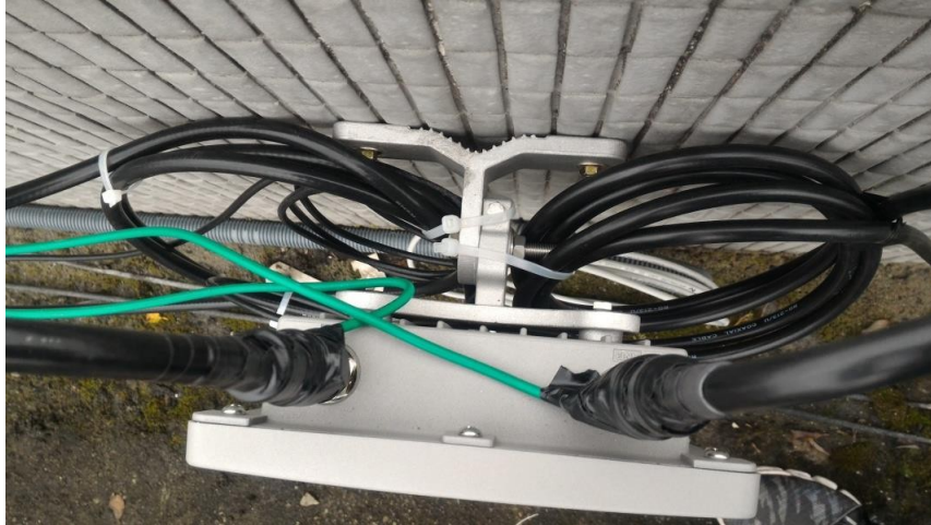
Abbildung 30 Blitzschutz- und Erdungsvorrichtungen – Bild 1
