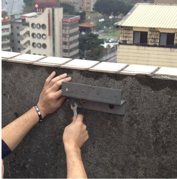
Abbildung 25 Maßgeschneiderte Metallhalterung – Bild 1
