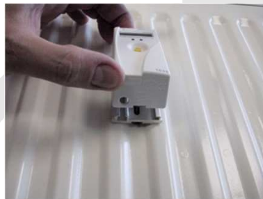
7-15 MONTAGE EHKV AUF WÄRMELEITER
