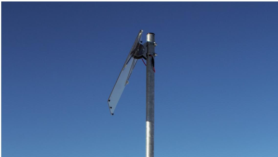
Montieren Sie das Solarpanel an einem Ort, an dem es tagsüber ausreichend Sonnenlicht erhält. Verwenden Sie Rohrschellen oder Metallbänder geeigneter Länge, um die Halterung am Mast zu befestigen.
