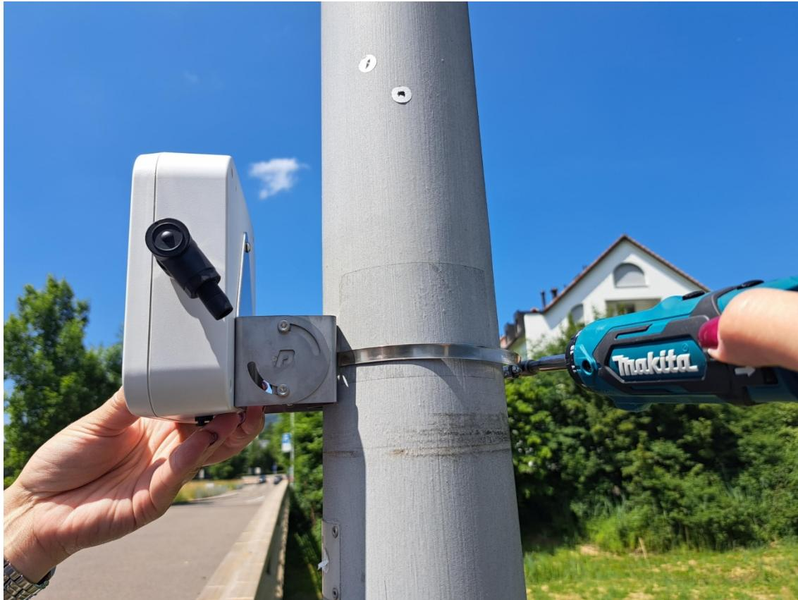
Wenn Sie den Zähler an einem Pfosten oder Mast montieren, verwenden Sie Rohrschellen oder Metallbänder geeigneter Länge, um die Halterung MT80-15 zu befestigen.
