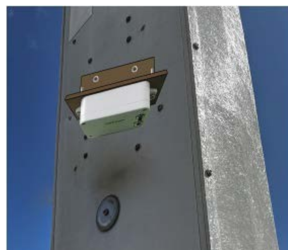
Abb. 2: Installation mit LED und Funktionstaste nach unten gerichtet.
