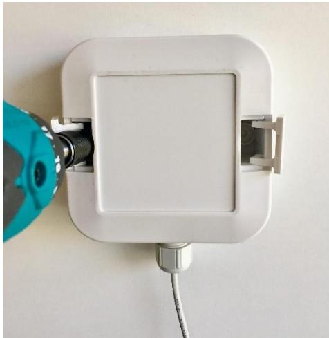
Stellen Sie sicher, dass die Kabelverschraubung vollständig angezogen ist. Öffnen Sie die Klappen an der Vorderseite des Gehäuses und schrauben Sie zwei Schrauben in die Wand.
